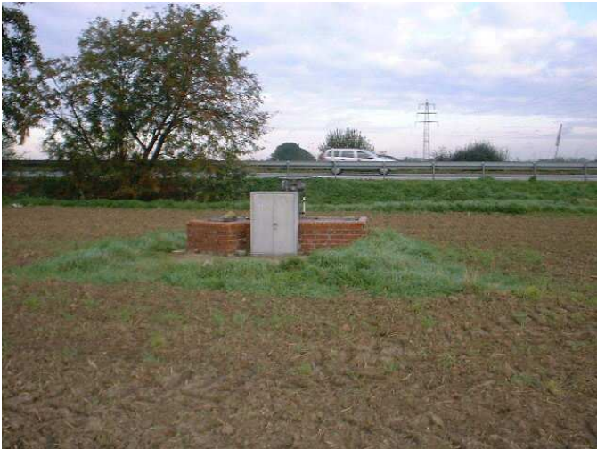
Bild 1: Kleines Pumpwerk zur Entwässerung weniger abgelegener Häuser
